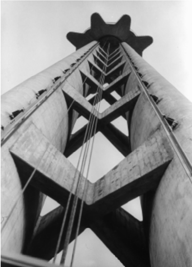
Hermes-Turm, Messengelände Hannover, 1955-56
